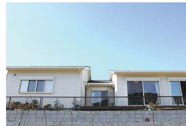
中央のウッドデッキの中庭を挟んで、左は親世帯の個室、右はリビング等の共用スペースと子世帯の個室を配置
